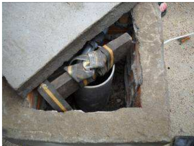
Photo hier das fertige Bohrloch Pumpe schon unten ca. 100 Meter tief
