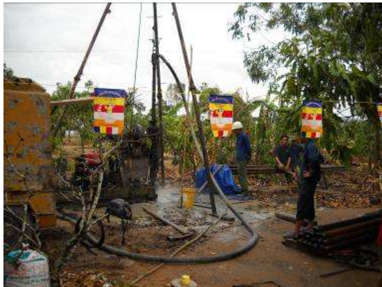
Photo: Ein Vinapro Motor treibt den Hammer an, der das Gestänge nach unten schlägt.
