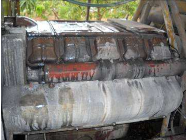
Photo: Der Kompressor hat ein Deuz Motor der Luftgekühlt ist. Das ist nicht ideal für Vietnam weil die Luft viel zu heiss ist in Vietnam. Man kühlt nun den Motor zusätzlich mit Wasser.
