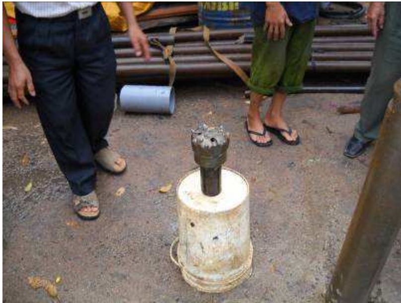
Photo: Hier nur der Bohrkopf
