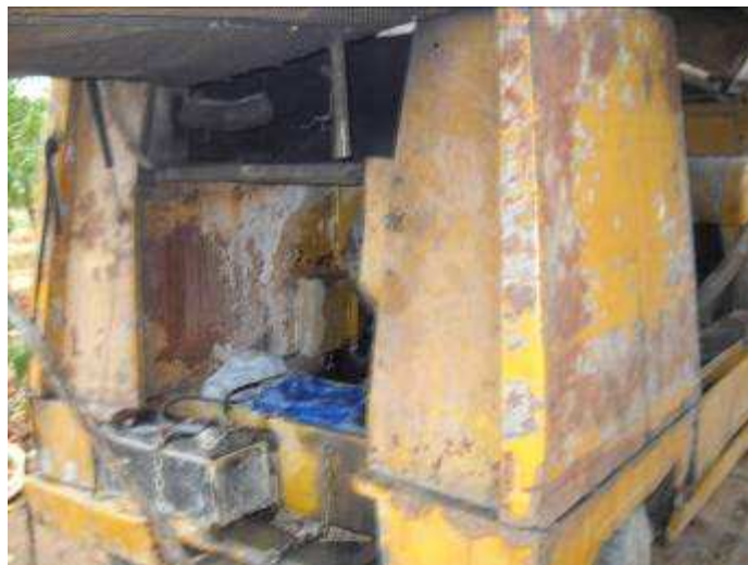
Photo: ja der Kompressor hat schon Gebrauchtsuren
