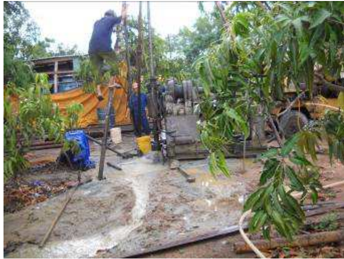
Photo: Mit einer hand voll flinken Leuten bohrt man in 2 Tagen ca. 100 Meter tief.
